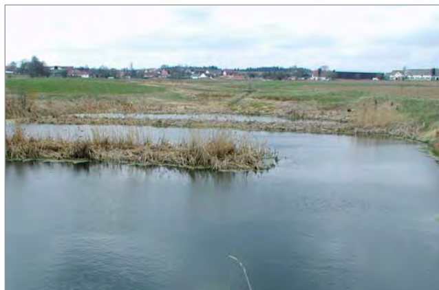
Jako mokřad mohou sloužit také čistící nádrže obecní kořenové čistírny, která je větší než třeba obdobná u domu. Obecní čistírna v Kamenici nad Lipou, jejíž výstavbu inicioval v 90. letech min. st. Ing. Šrůtek, ekozemědělec. FOTO – Miloslav Vohralík
